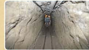
EL ALTIPLANO. El túnel para su segunda fuga en julio de 2015.
