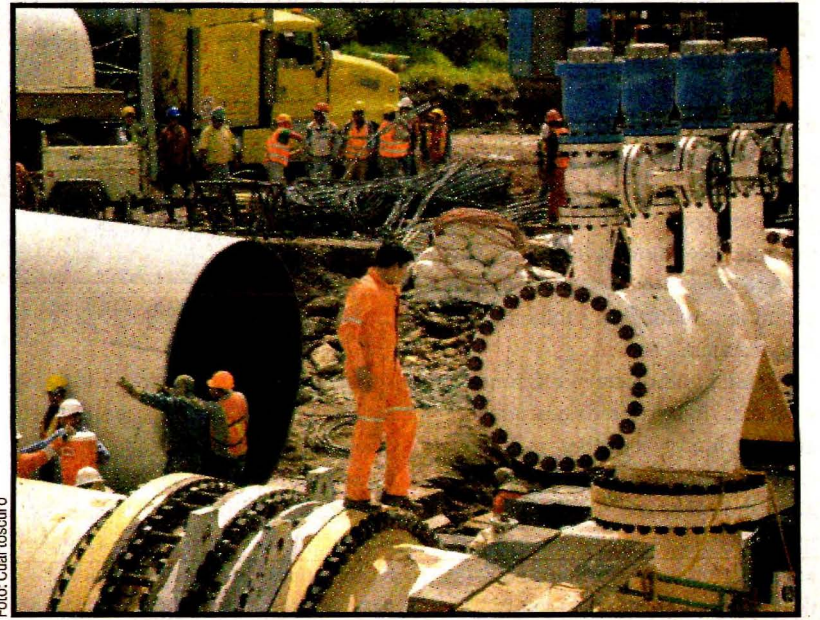
Los trabajos en el Cutzamala fueron infructuosos. Falló la K invertida por cuatro centímetros.
